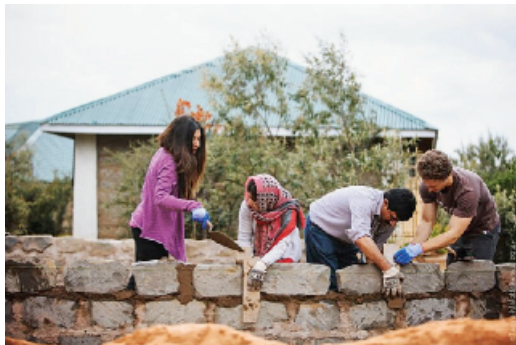
Construyendo un muro de una escuela en Masái Mara, Kenia, con Malala y Craig Kielburger, cofundador de Free the Children.
